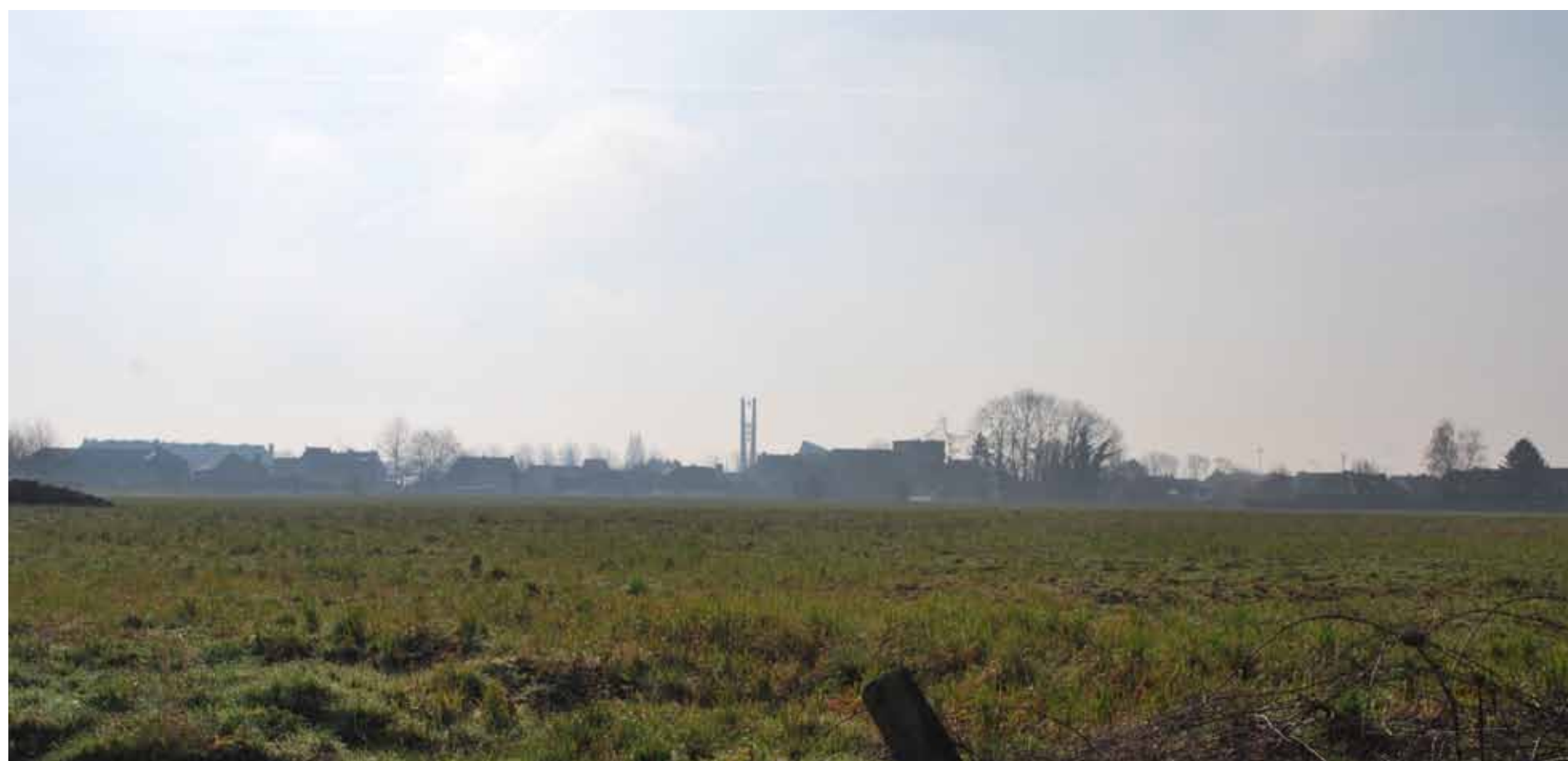
FOTO GENOMEN OP DE STOKERIJSTRAAT OP DE GRENS VAN HET PLANGEBIED, MET OP DE ACHTERGROND ZICHT OP DE SINT-PIETERSKERK.
