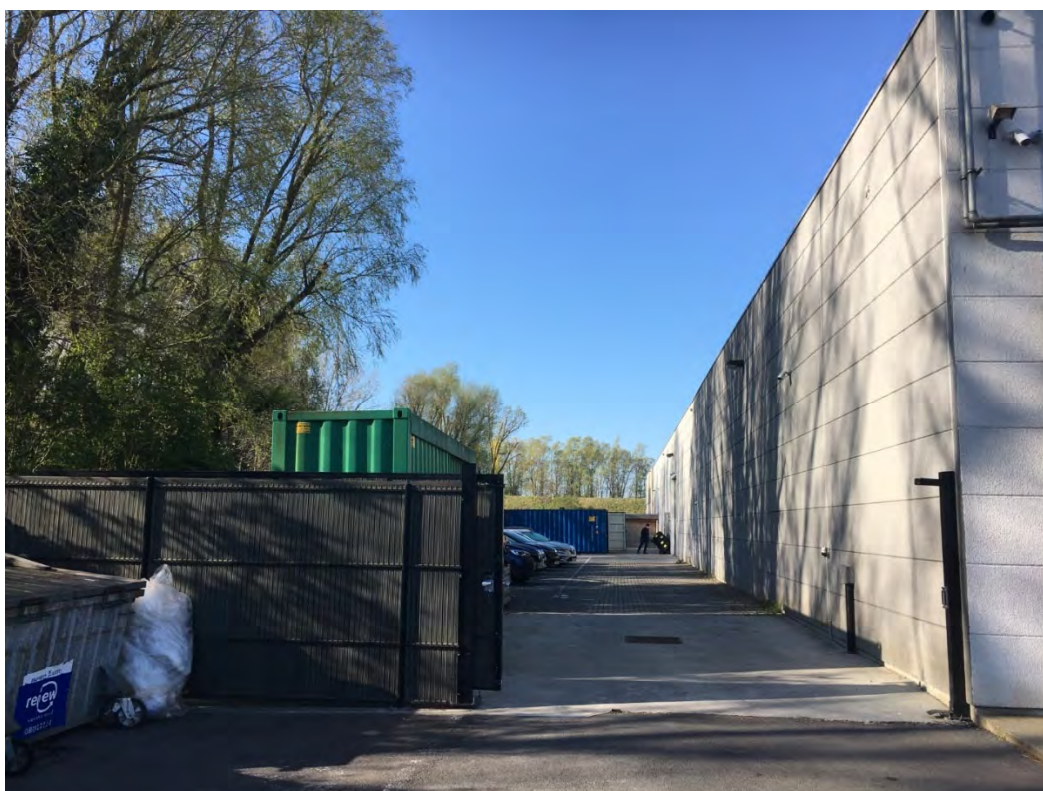
Beeld te ontgraven zone gezien vanuit het noorden.
