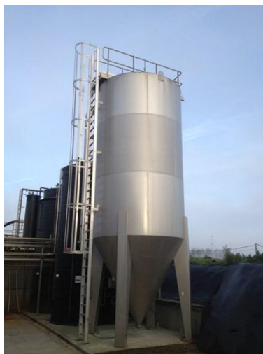
Figuur 26 Zandfilter voor fosfaatprecipitatie en denitrificatie
