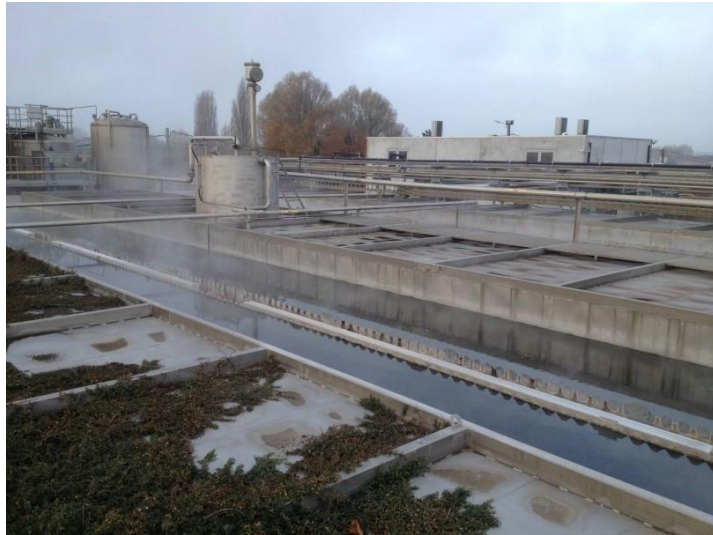
Figuur 22 UASB-reactor
