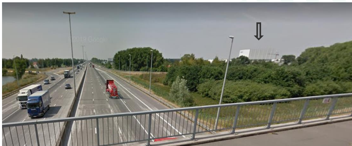
Figuur 59 Diepvriesgebouw Agristo Nazareth (bron: Google Maps)
