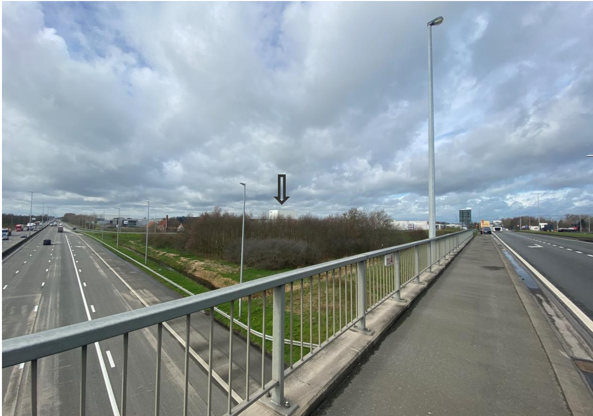
Figuur 60 Diepvriesgebouw Nazareth (bron: eigen fotomateriaal)
